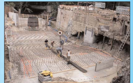
Arbeiten an der Einlaufsohle unter Zeitdruck
