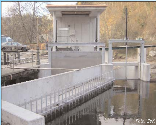
Modernes Kleinwasserkraftwerk made by GHE: KW Herrenmühle
