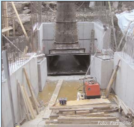
Auslaufbauwerk mit Saugrohr in der Bauphase
