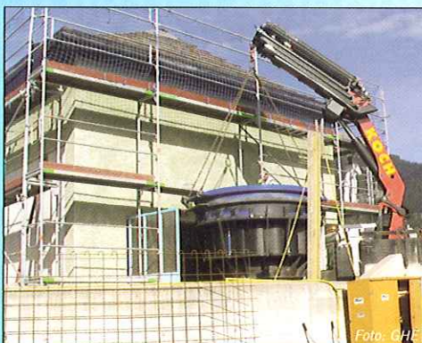
Aufgrund beengter Platzverhältnisse wurde das Versetzen der GHE-Schachtturbine zum „Einfädeln“
