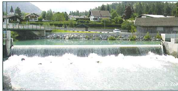
Die pfeilerfreie Überfallschwelle verhindert nun Verkläusungen
