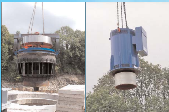
Einheben von Leitapparat und Generator: Der Kranführer braucht dafür eine sehr ruhige Hand. Foto: GHE / Kühhas
