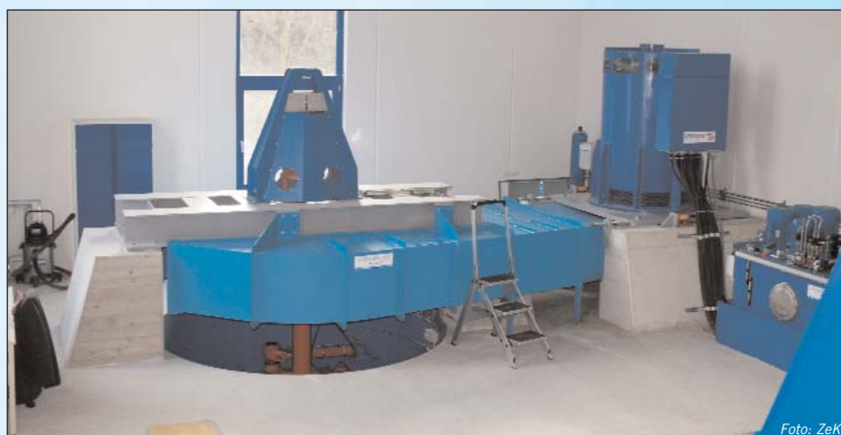
Eine von zwei baugleichen Maschinensätzen im Krafthaus. Die vertikale Schachtturbine von GHE treibt über einen Riemen den Drehstrom-Synchrongenerator aus dem Hause Hitzinger an.
