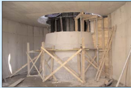
Ungewohnter Blick in Richtung Turbineneinlauf
