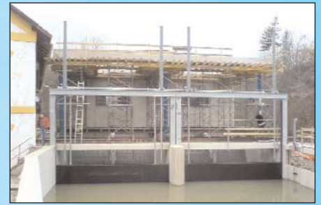
Stahlwasserbau kam ebenfalls von GHE Fotos: Kühhas
