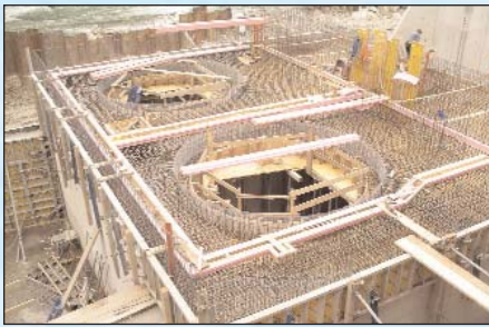
Auslässe für den Leitapparat im Rohbau (li)
