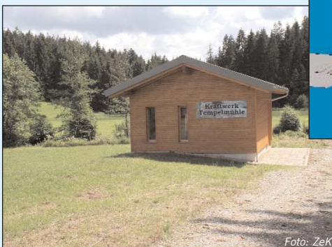
Für den Sägewerksbetreiber war es eine Selbstverständlichkeit, sowohl das Krafthaus (li) als auch das Einlaufgebäude in Holzbauweise zu errichten. Die Grafik (oben) zeigt einen Querschnitt durch das Krafthaus.
