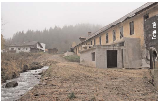
Oben: Neben dem Krafthaus schlängelt sich der Arberseebach vorbei, von dem Triebwasser für die Durchströmturbine abgezweigt wird. Rechts: Für den Einbau der neuen Kaplan-S-Rohrturbine stand lediglich eine Breite von 2,50 m zur Verfügung. Das reichte aus.
