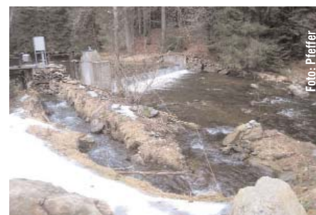
oben: Wehranlage an der Regen. Hier wird das Wasser für das KW Seebachschleife ausgeleitet. Ein naturnaher Fischpass macht den Querverbau passierbar.
