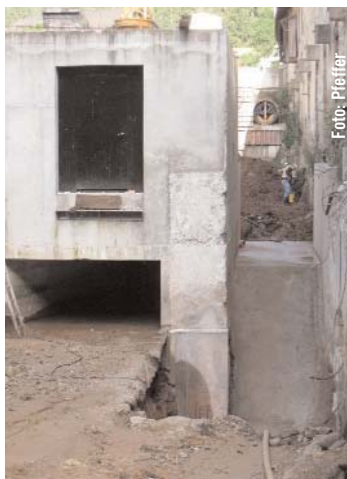
Oben: Neben dem Krafthaus schlängelt sich der Arberseebach vorbei, von dem Triebwasser für die Durchströmturbine abgezweigt wird. Rechts: Für den Einbau der neuen Kaplan-S-Rohrturbine stand lediglich eine Breite von 2,50 m zur Verfügung. Das reichte aus.
