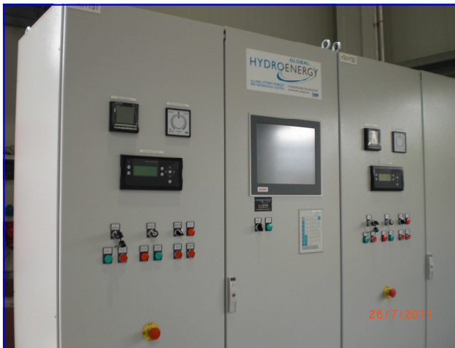
Turbinenregelung turbine governor
