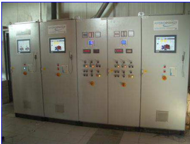
Turbinenregelung turbine governor
