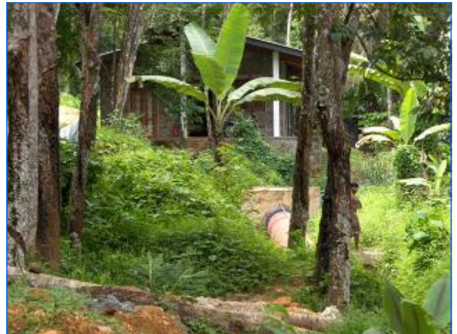
Einlaufrohrleitung Inlet penstock
