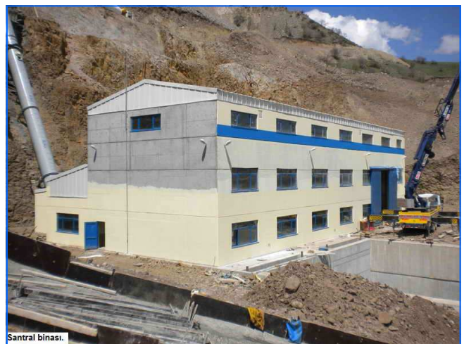
Außenansicht des Kraftwerks Outside view of the powerhouse
