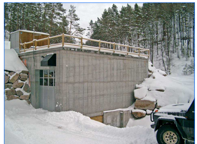
Inbetriebnahme bei Schneefall in Norwegen Installation with snowfall in Norway
