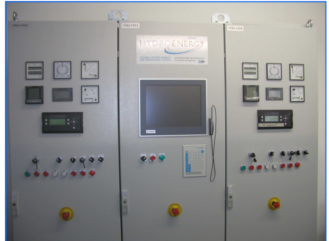
Turbinenregelung turbine governor
