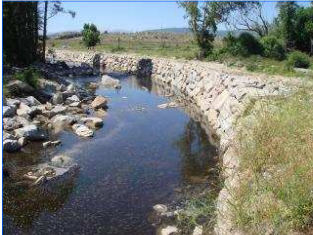
Einlaufkanal Intake channel
