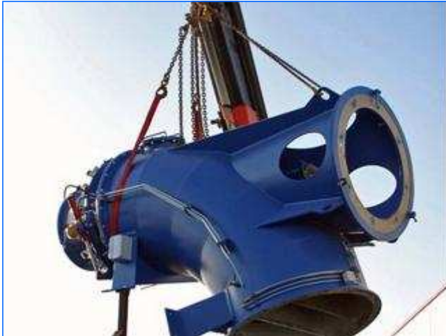
Montage Turbine mit Kran Assembly turbine with crane
