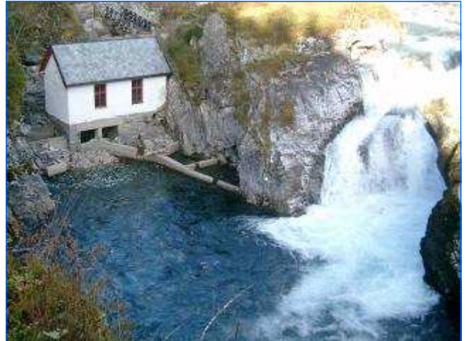
Das alte Turbinenhaus vor dem Umbau The old turbine house before the rebuilding
