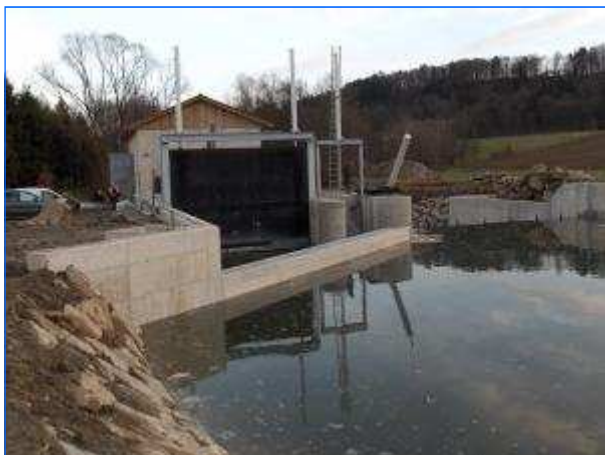
Einlauf mit Einlaufschütz, Leerschusschütz u. Stauklappe Intake with intake gate, bypass gate, wire gate
