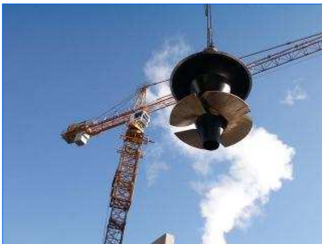
Montage Laufrad mit Kran Assembly runner with crane
