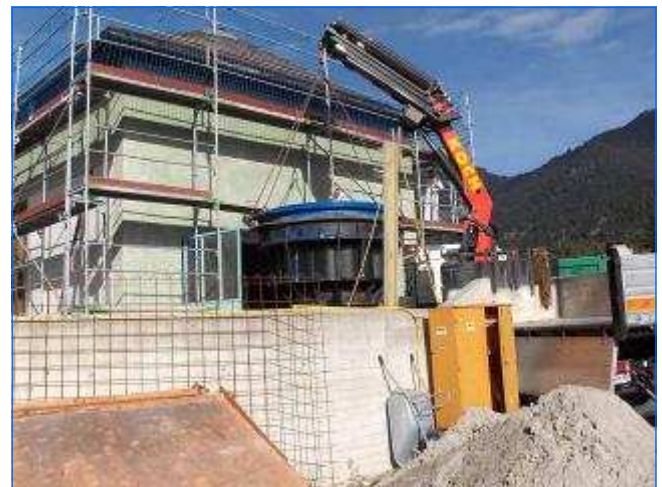
Baustelle Pflach Construction site Pflach
