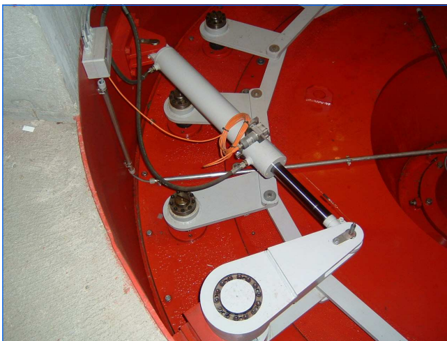
Leitapparat Guide vane ring
