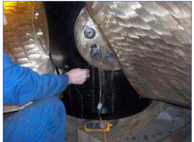
Kaplanflügel Einbau mit Dehnschrauben Kaplan blade assembly with extension bolt
