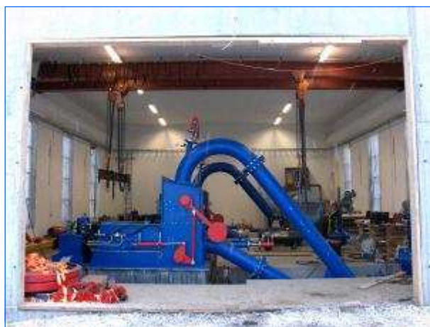
Pelton turbine beim Einbauort Pelton turbine at installation site
