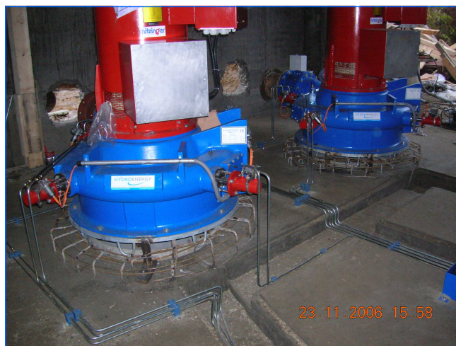
Turbine mit Generator vor abschließender Betonarbeit Turbine with Generator before concrete workings
