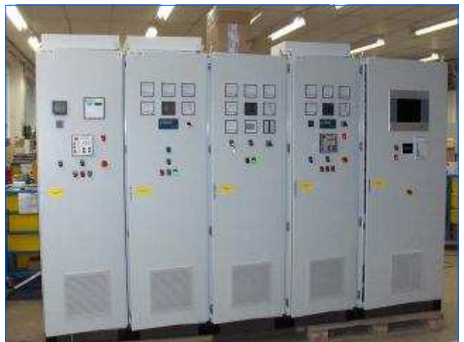
Schaltanlageanlage bei HYDRO ENERGY Switch gear montage at HYDRO ENERGY
